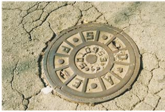
[Figure 02] Manhole cover, Rua Américo Brasiliense, São Paulo (2005).
