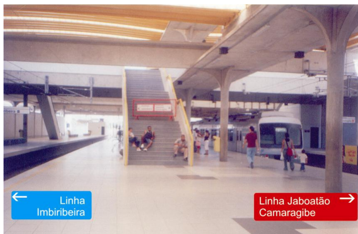
Figura 4: A plataforma de embarque e desembarque apresenta sinalização deficiente.
